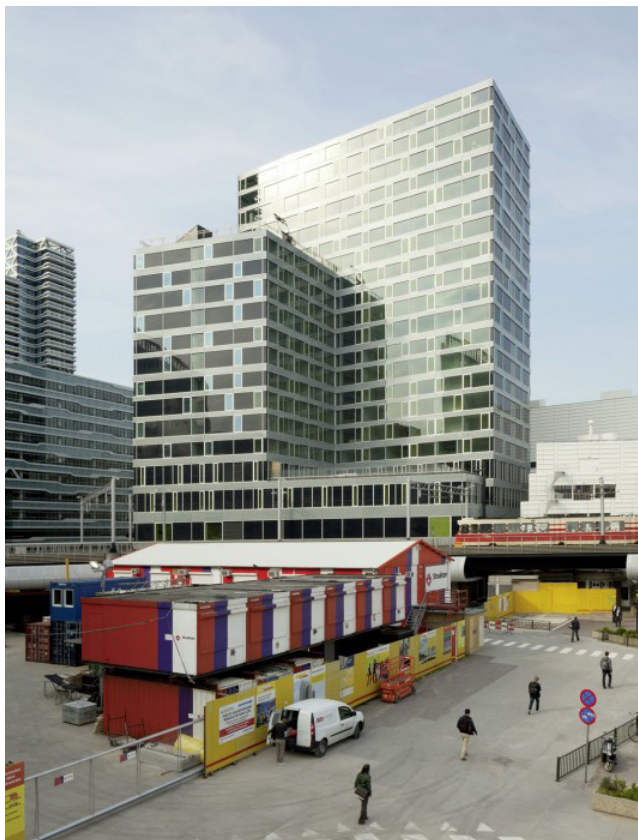
WIEL ARETS - AVB TOWER - DEN HAAG
