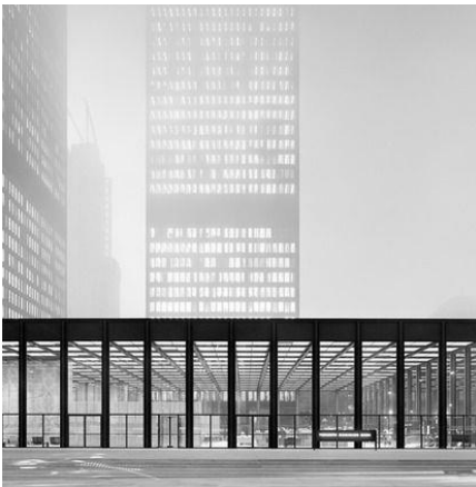
MIES VAN DER ROHE - DOMINION CENTRE - TORONTO
