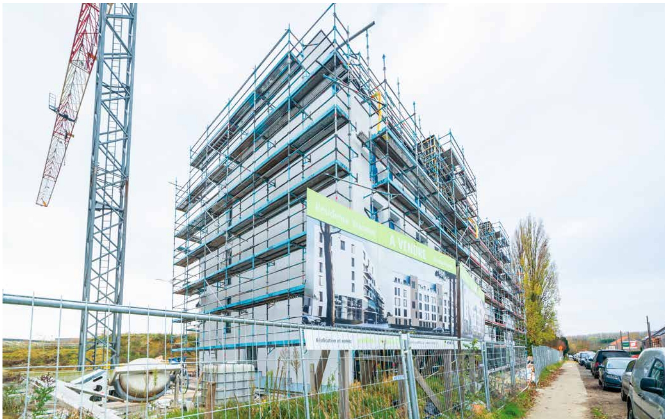
↑ Construction de logements route de Lennik (Erasmus). Bouw van woningen Lenniksebaan (Erasmus).
