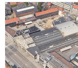
Bruxelles Propreté Réseau de recyclage
