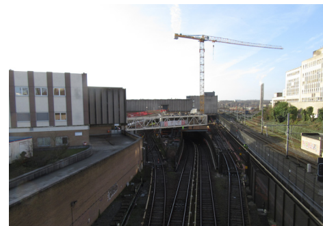
Zicht van de spoorweg en de MIVB-stelplaats in Delta
