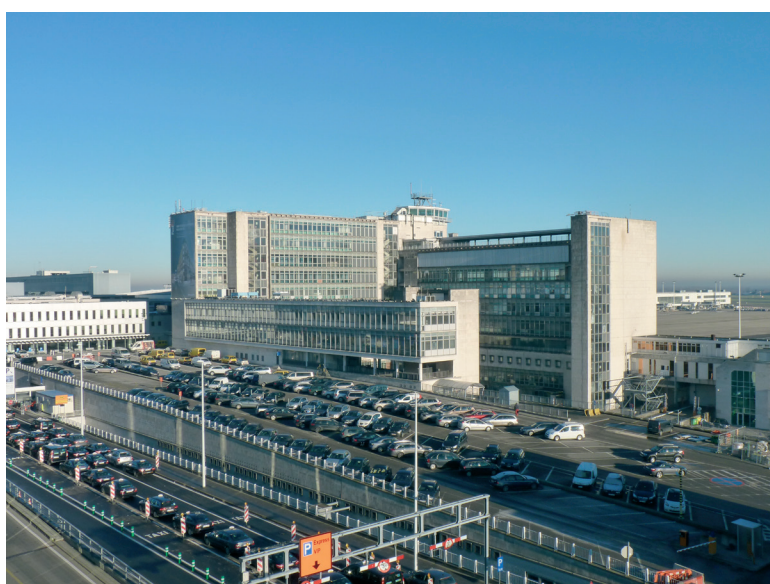
Gateway, rénovation de l'ancien immeuble administratif de l'aéroport. Gateway, renovatie van het oude administratieve gebouw van de luchthaven. Gateway, renovation of the airport's former administrative building.
