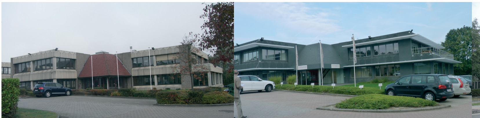
2010-2013, avant-après : rénovation au Keiberg Park (Zaventem). 2010-2013, Keiberg Park (Zaventem), voor en na renovatie. 2010-2013, Keiberg Park (Zaventem), before and after renovation.
