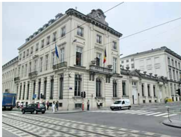
Le SPF Intérieur, rue de la Loi 2 / De FOD Binnenlandse Zaken, Wetstraat 2 / The FPS Interior, 2 Rue de la Loi
