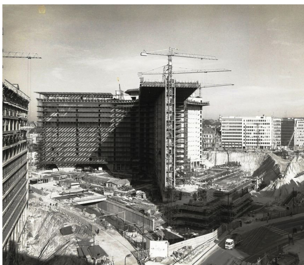
Bouw van het Berlaymont-gebouw, 1964
