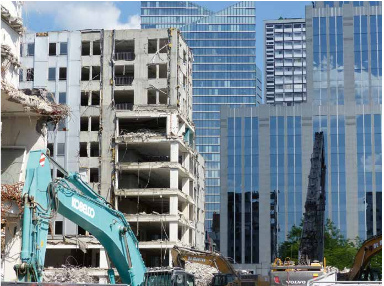
↑ Démolition boulevard Baudouin, en vue de la construction du projet Quatuor (quatre tours de bureaux et commerces). Afbraakwerken Boudewijnlaan, voor de bouw van het project Quatuor (vier kantoortorens en handelszaken).
