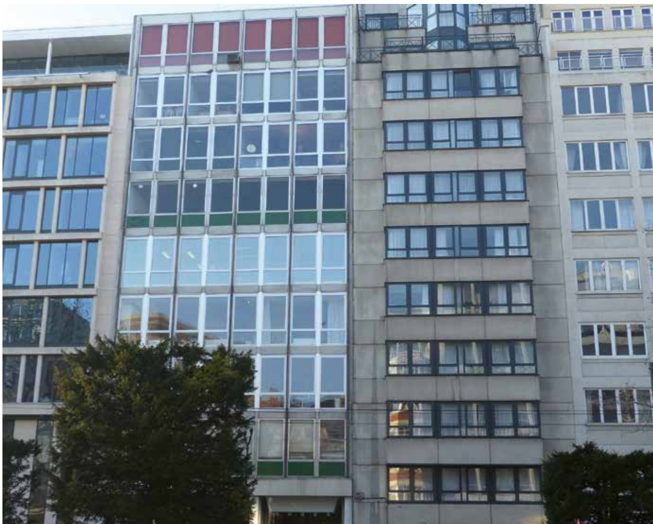
↑ Front bâti avenue Louise. De gauche à droite : immeuble de bureaux E-Lite, ayant bénéficié d'une rénovation lourde en 2013 ; un immeuble de bureaux en copropriété, construit en 1973, offrant des plateaux d'environ 240 m 2 ; un ancien immeuble de bureaux construit en 1974 et transformé en logements et un immeuble à appartements construit au début des années 50.
