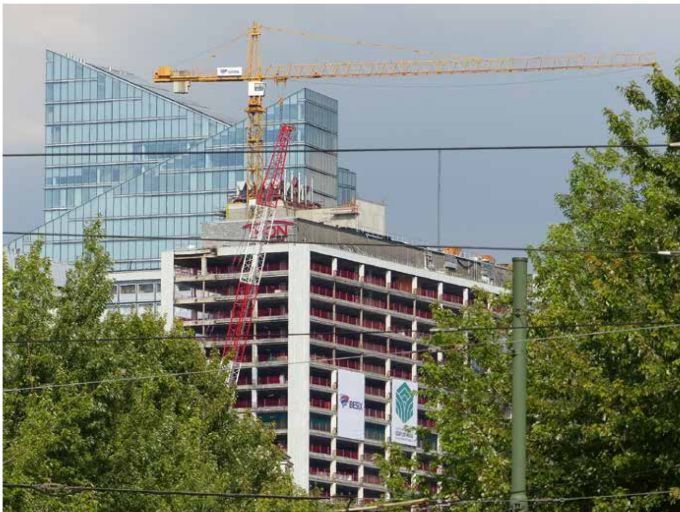
↑ Rénovation lourde du Manhattan Centre (avenue du Boulevard). Ingrijpende renovatie van het Manhattan Centre (Bolwerklaan).
