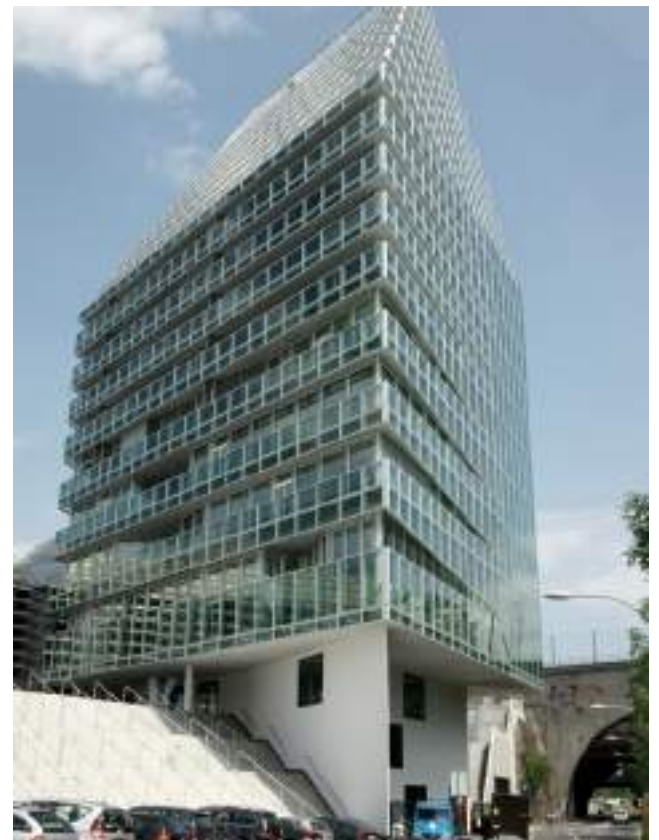
HERZOG & DE MEURON - ST JAKOB TURM - BÂLE
