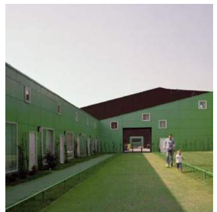
MVRDV - MAISON YPENBURG - DELFT
