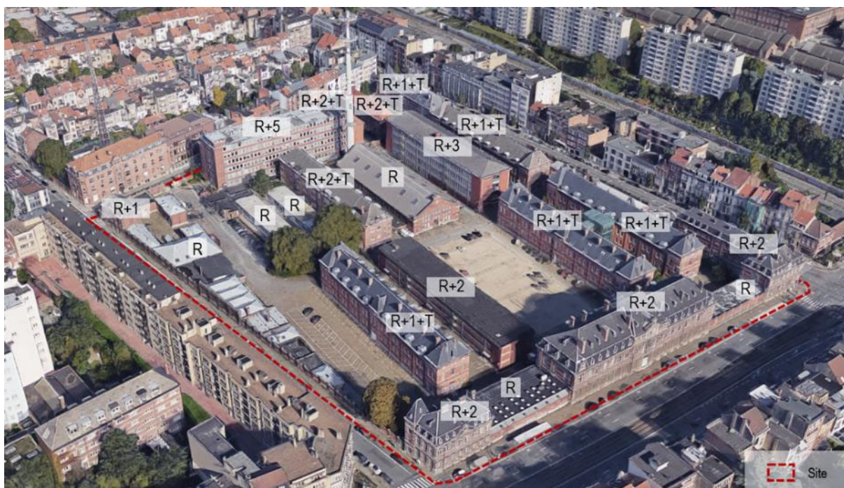
Figuur 28: Bouwprofielen aan de binnenkant van de site (ARIES op Google Maps-achtergrond, 2017)
