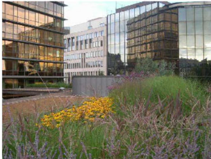
Figuur 332: Semi-intensief dak, kantoorgebouw in Elsene (landschapsarchitect: Bernard Capelle 2003)
