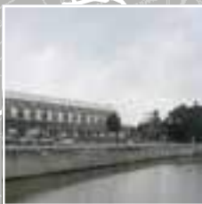
Ensemble centrale électrique
