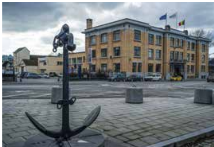
▲ Le siège de la société du Port, à la place des Armateurs
