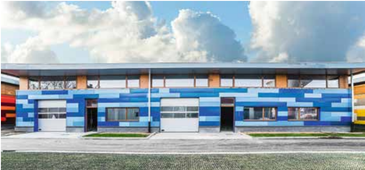
▲ Le nouveau Parc PME de Citydev.brussels, boulevard Paepsem à Anderlecht.
