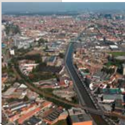
▼ Pont de Cureghem vers Saintelette
