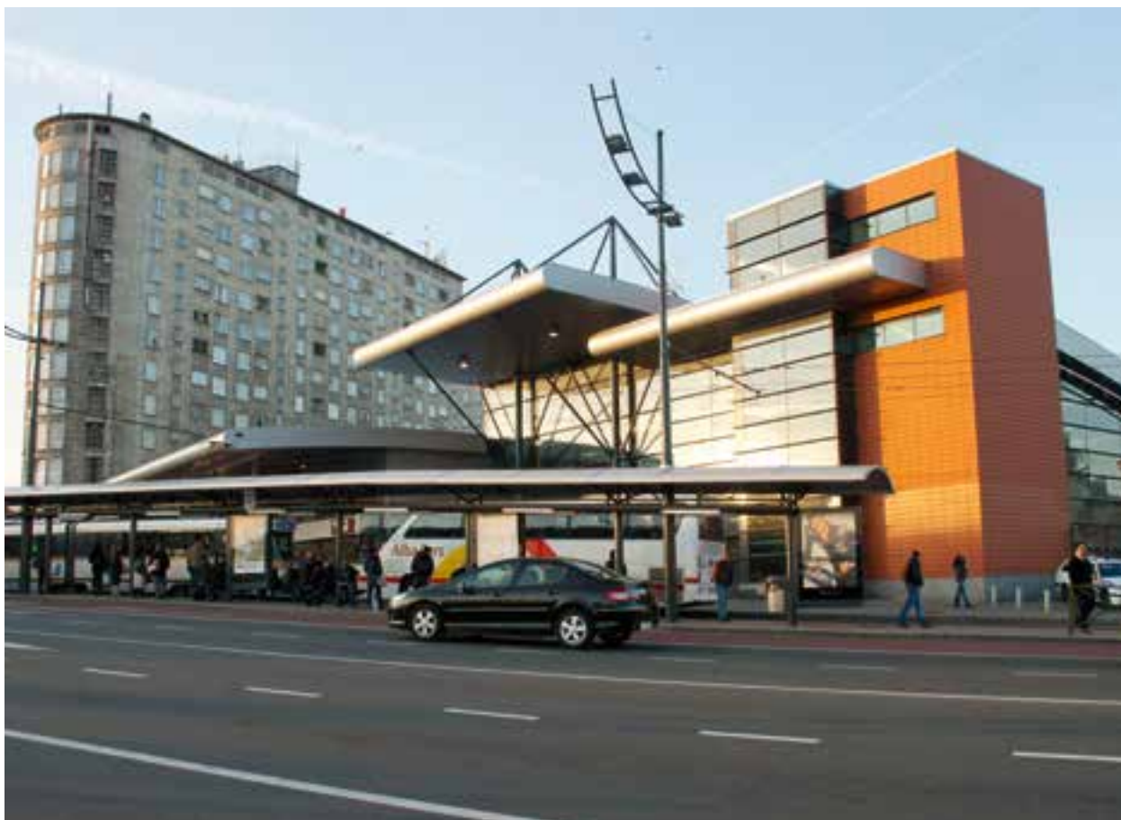
▲ La station de métro Gare de l'Ouest
