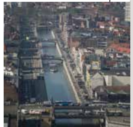
▲ Vue de la place Saintelette vers la Porte de Ninove
