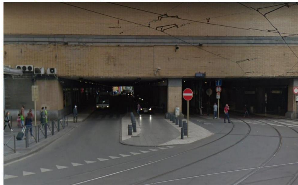
UNE INFRASTRUCTURE FERROVIAIRE STRUCTURANTE - DES SOUS-FACES À AMÉNAGER
