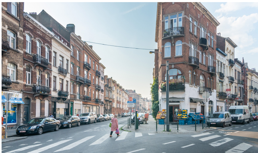
↑ Photo 10 : Bâti typique des quartiers de première couronne (© perspective.brussels / Pedro Correa)
