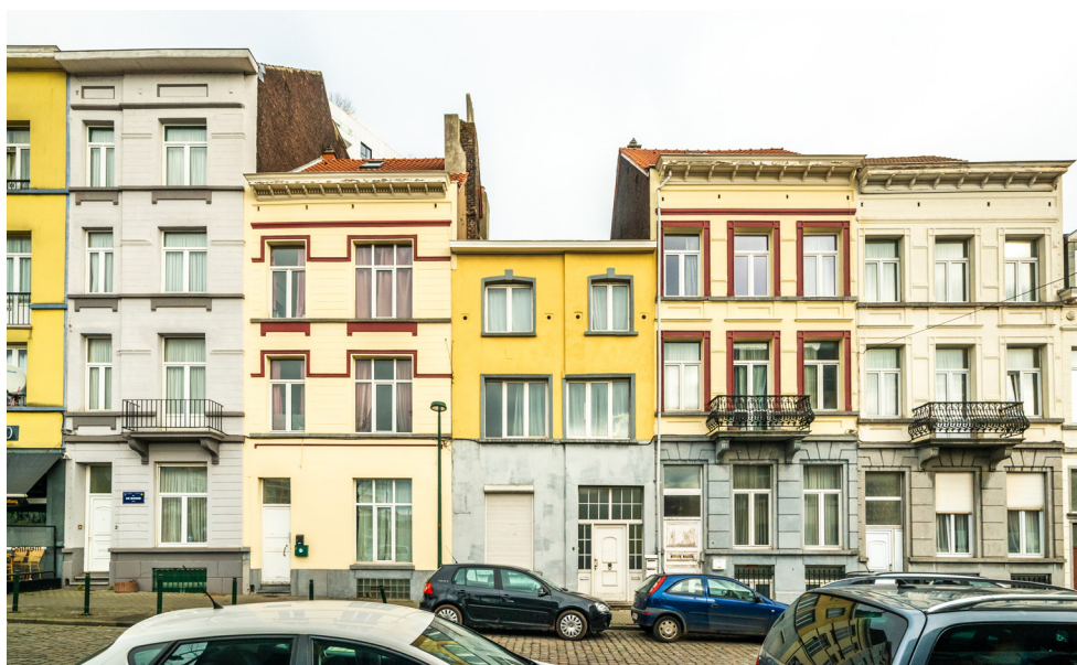
↑ Photo 12 : Variation de hauteurs de bâtiment au sein d'un front bâti (© perspective.brussels / Pedro Correa)
