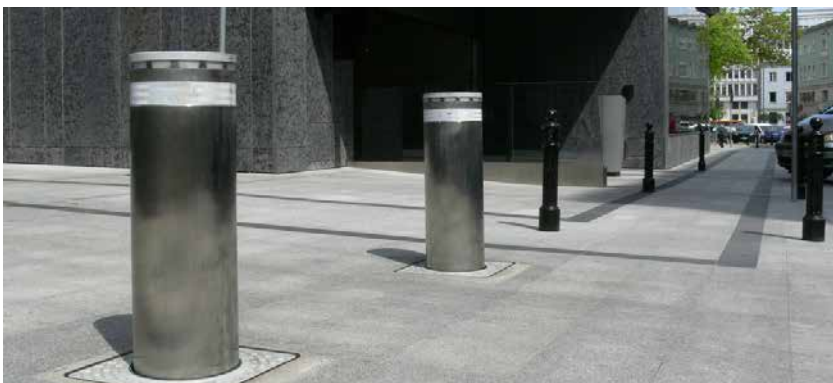
↑ Exemples de bollards rétractables et télescopiques
