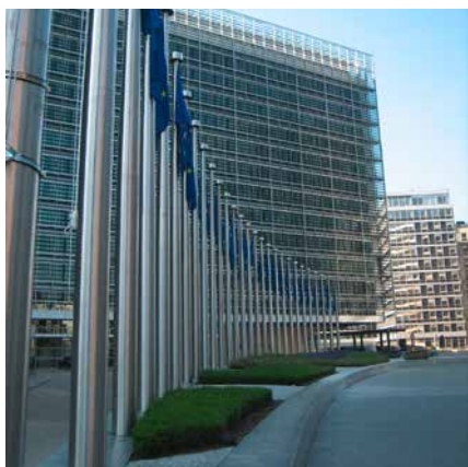
↑ Bordure de protection Boulevard Charlemagne, Bruxelles
