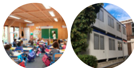
Modules préfabriqués en bois
