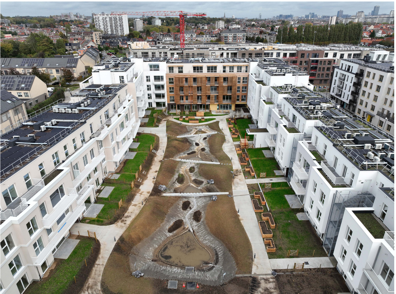
↑ Projet / Project Fonds du Logement / Woningfonds - Trèfles 2 / Klaver 2 © Serge Brison
