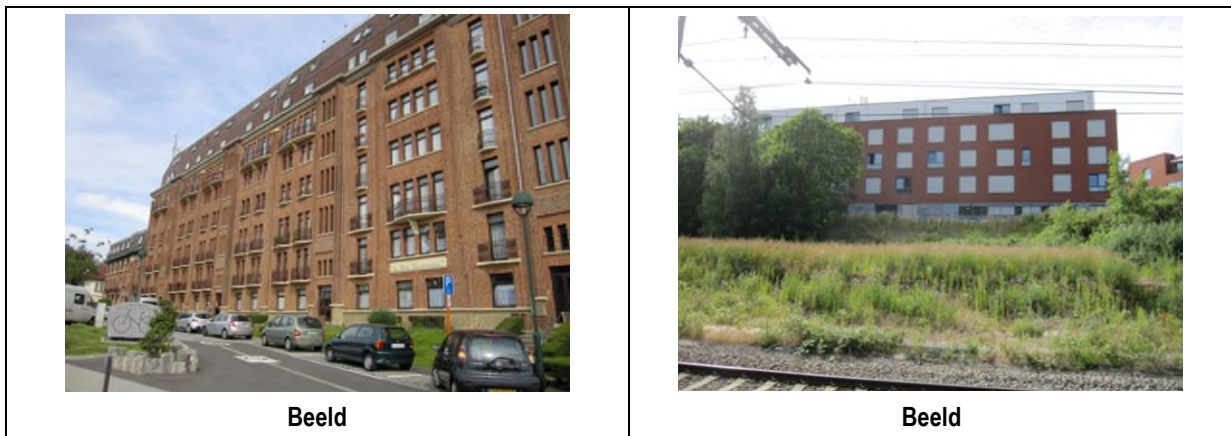
Afbeelding 41 : Mandelig gebouw (Schaarbeekse Haard) en bouwwerk op het binnenterrein van het huizenblok in het westen (Google Street View en ARIES, 2021)
