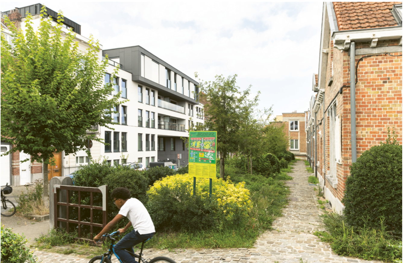
↑ Photo 8 Nouveaux logements rue des Cultivateurs, Etterbeek (septembre 2024) Foto 8 Nieuwe woningen Landbouwersstraat, Etterbeek (september 2024)
