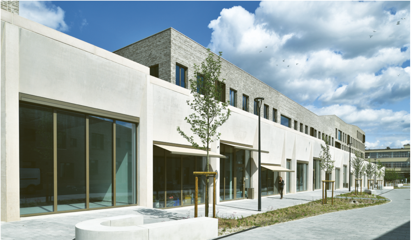
↑ Photo 7 Ateliers au rez-de-chaussée dans le projet CityCampus, avenue Gryson, Anderlecht © Serge Brison, mai 2023 Foto 7 Gelijkvloerse werkplaatsen in het project CityCampus, Grysonlaan, Anderlecht © Serge Brison, mei 2023
