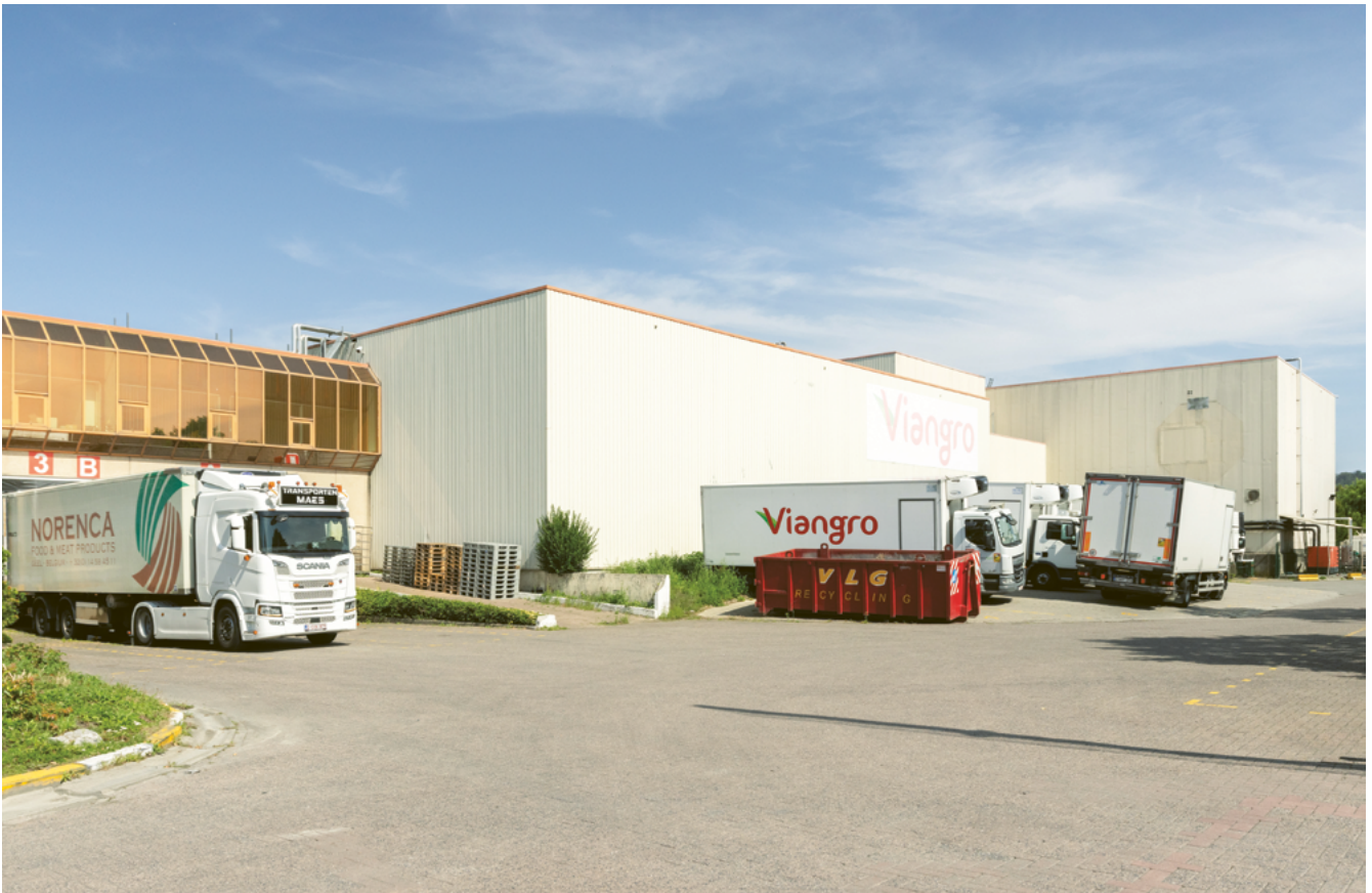
↑ Photo 14 Entreprise de transformation de la viande Viangro, rue de Bienvenue, Anderlecht (septembre 2024) Foto 14 Vleesverwerkend bedrijf Viangro, Verwelkomingsstraat, Anderlecht (september 2024)
