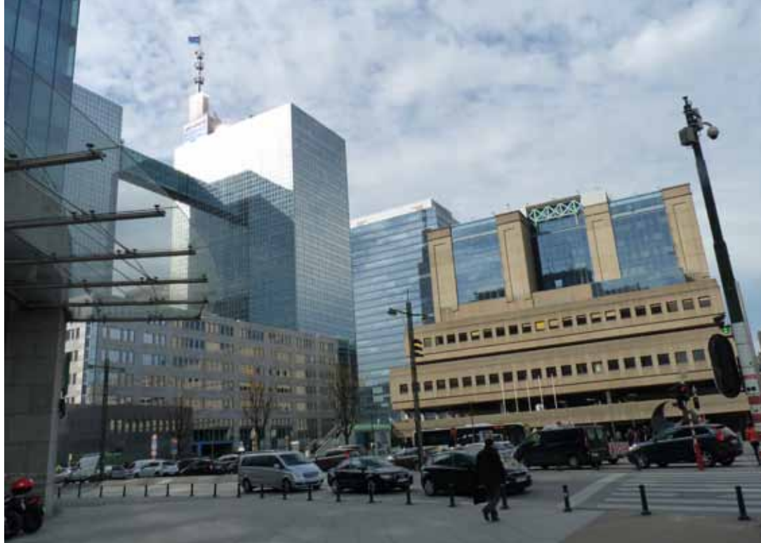
À gauche Proximus, à droite le Centre de Communication Nord Links: Proximus. Rechts: het Communicatie Centrum Noord Left: Proximus. Right: Centre de Communication Nord
