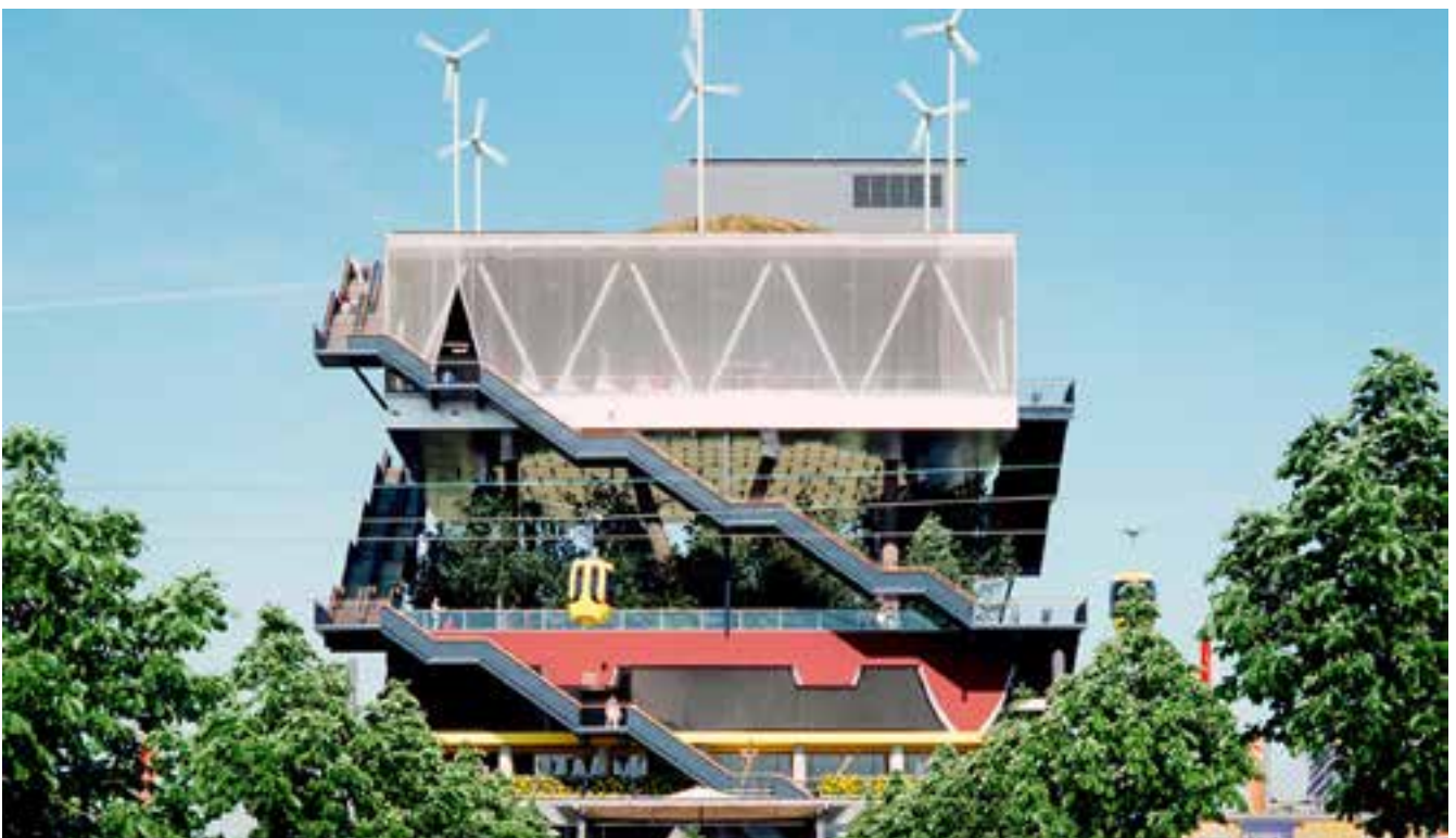
↑ Een iconisch gebouw met een duidelijke architectuurtaal.
