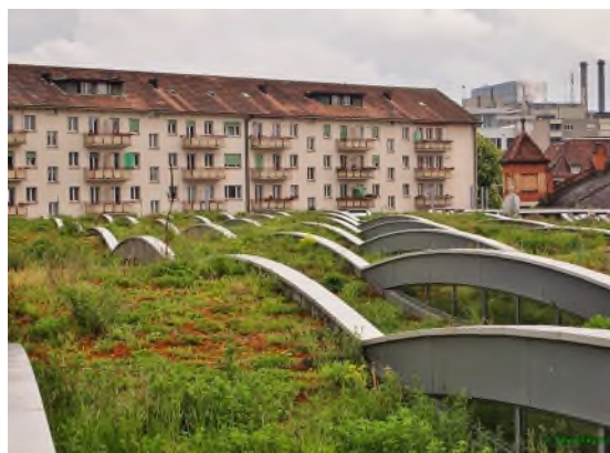
Figure 148 : Toit végétalisé du dépôt de Tram de la ville de Bâle - Un projet innovant : une construction légère avec une couche drainante en paille de miscanthus de 10cm ( http://naturetoit.blogspot.com/2014/07/le-wiesenteppich-de-bale.html )
