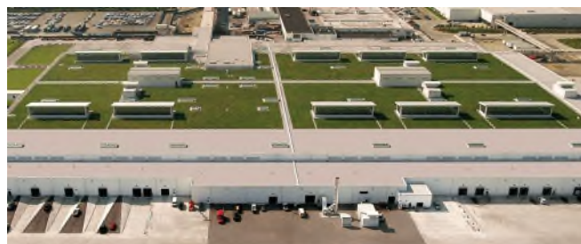
Figure 147 : Exemple de toiture verte sur structure légère - Ford Motor Company's River Rouge Truck Plant ( www.greenroofs.com )
