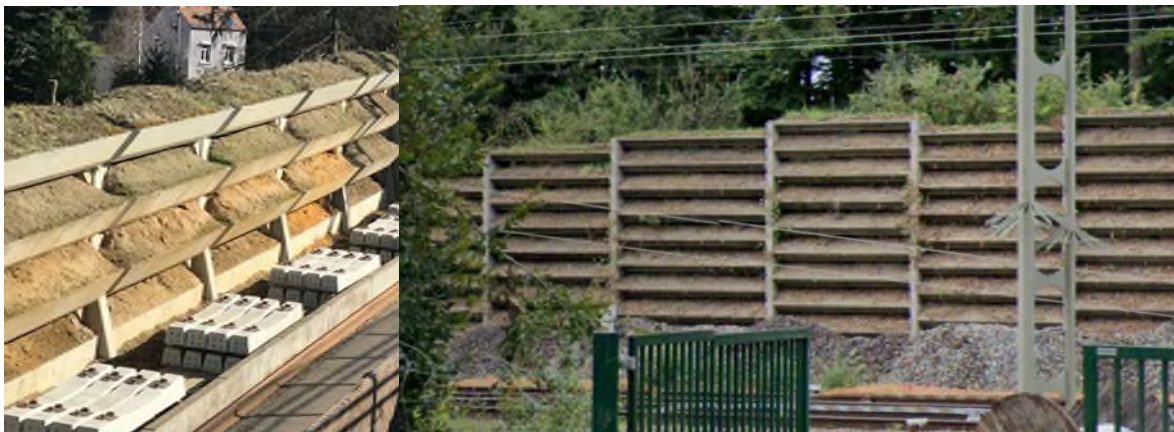
Figure 149 : Exemple de mur anti-bruit construit pour le RER bruxellois (INFRABEL.be)
