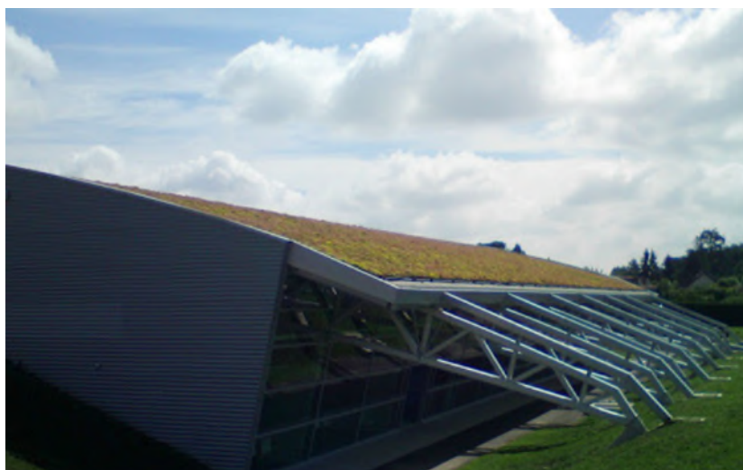
Figure 146 : Exemple de toiture verte sur structure légère : Gymnase de St Genis Laval - Le Prieuré Vegetal i.D. ( http://www.vegetalid.fr )
