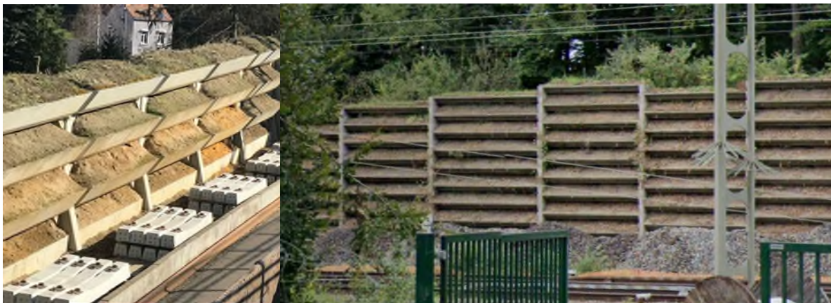
Figure 64 : Exemple de mur anti-bruit construit pour le RER bruxellois (INFRABEL.be)
