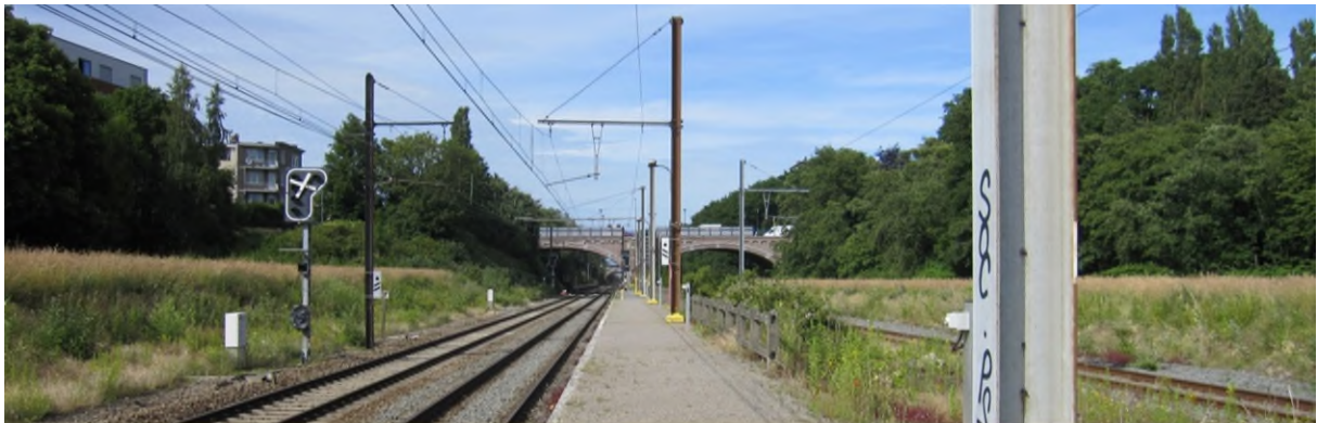
Figure 17 : Vue depuis le site vers le nord (ARIES, 2021)
