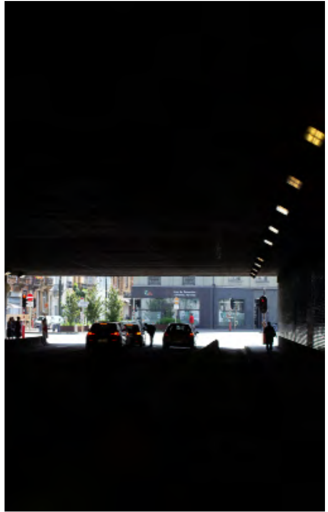
Tunnel van de Veeartsenstraat naar de Fonsnystraat en de Koningslaan.
