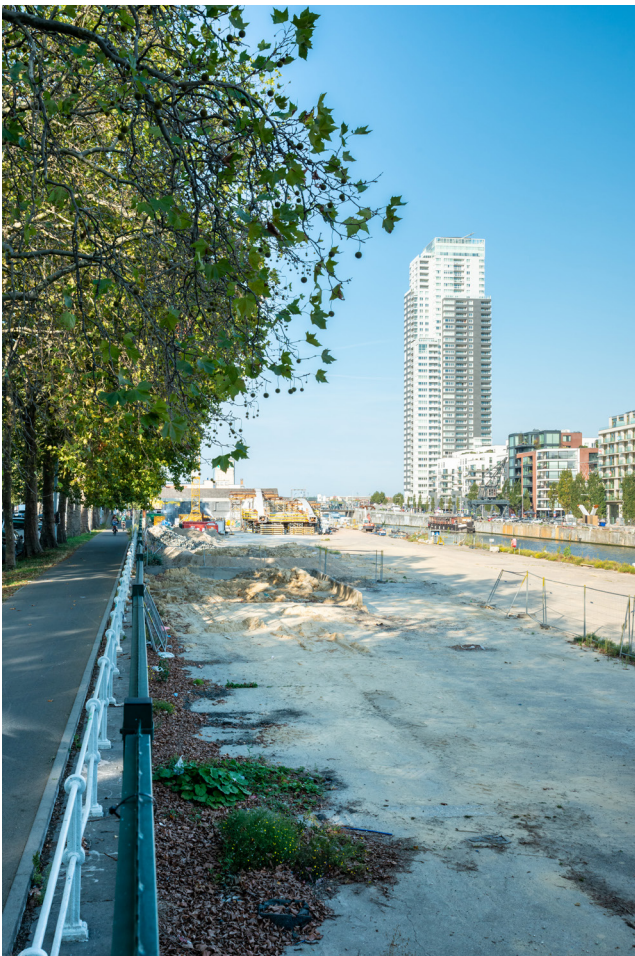
↑ Travaux en vue du futur Parc régionale au Quais des Matériaux. ©perspective.brussels/Pedro Correa
