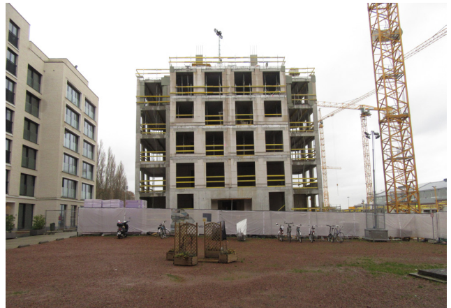
↑ Maison de repos et de soins en construction; zone C Tour8Taxis, perspective.brussels, 2020
