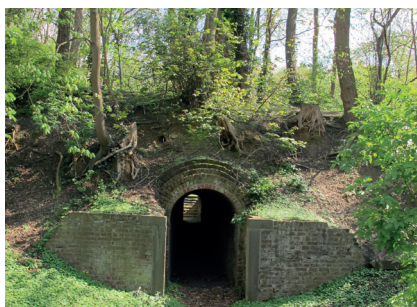
↑ Tunnel en greppel van de Nationale Schietbaan
