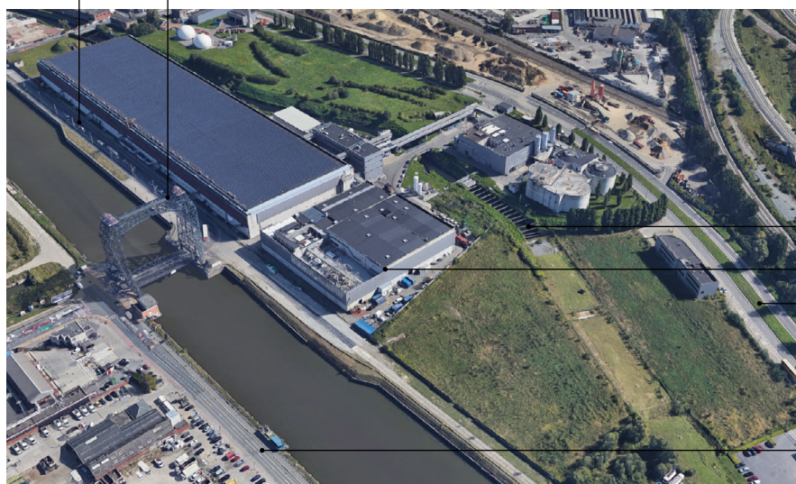
Digue du Canal Pont de Buda
