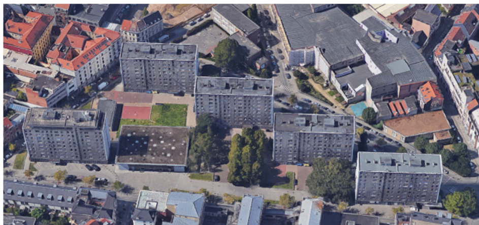
Tours de logement, Rempart des Moines (photo Google maps, 2015)
