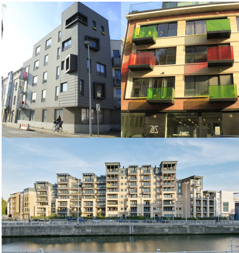
Opérations de logement autour de la Porte de Ninove (photos : perspective. brussels, 2016 et Citydev.brussels)
